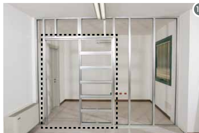
Фаза 18 Закрепить вертикальные стойки (f) и (c) к металлическому каркасу проема (Саморезы в комплект не входят).
