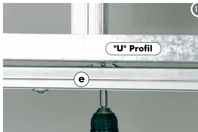
Фаза 17 Закрепить траверсу с рельсом (e) к элементам проема используя саморезы.
